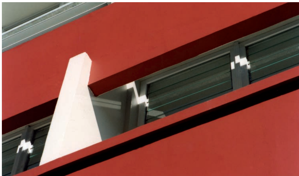
Ventilation et brise-soleil en façade avant.
